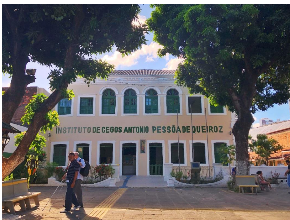
Figura 19 - Fachada do IAPQ
