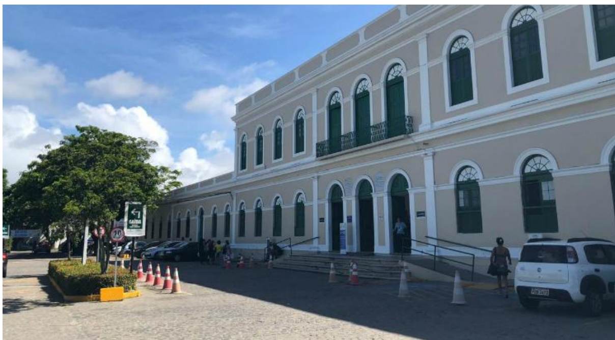
Figura 5 - Fachada do Hospital Santo Amaro
